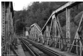
Wyróżnienie – Artur Górni – Wiadukt kolejowy
